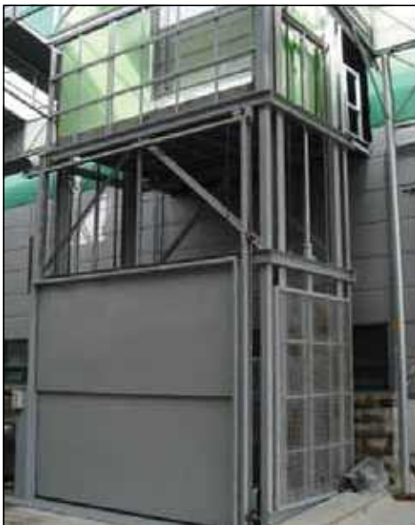
▼ 공장 내부설치 모습
